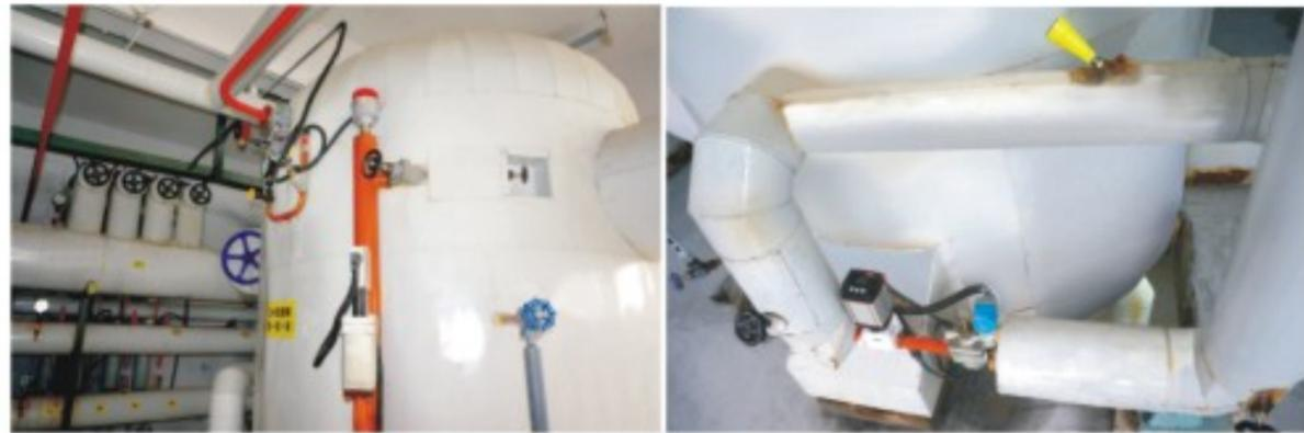
图三、A+B 冷库中新型液位传感器AKS 4100+EKE347及控制器产品ICM+ICAD的低压循环桶液位控制解决方案
