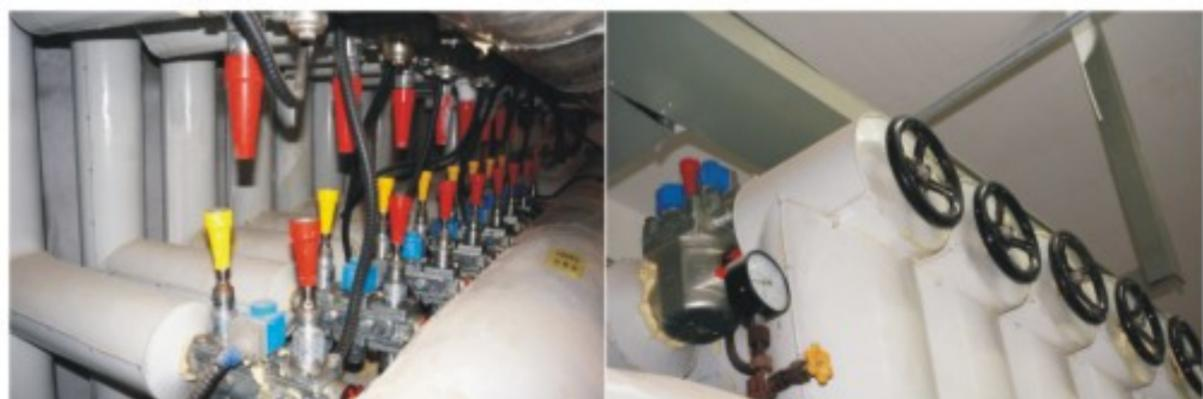
图二、A+B 冷库中安装的丹佛斯ICF 组合阀+ICLX两步开启式电磁阀的热气融霜自动控制解决方案
